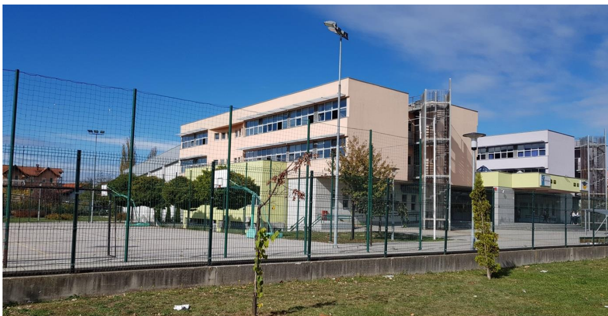
Zgrada Pete gimnazije (lijevo krilo) i Gimnazije Dobrinja (desno krilo)
